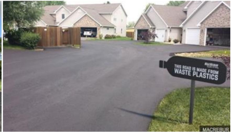
写真：英国MacRebur社のプラスチックゴミ活用アスファルト舗装（同社HPより）
